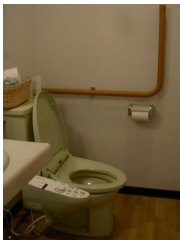
トイレに手すりがつきました!
